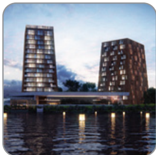
Inwestycja w Kudowie-Zdroju
