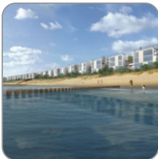
Boulevard Ustronie Morskie
